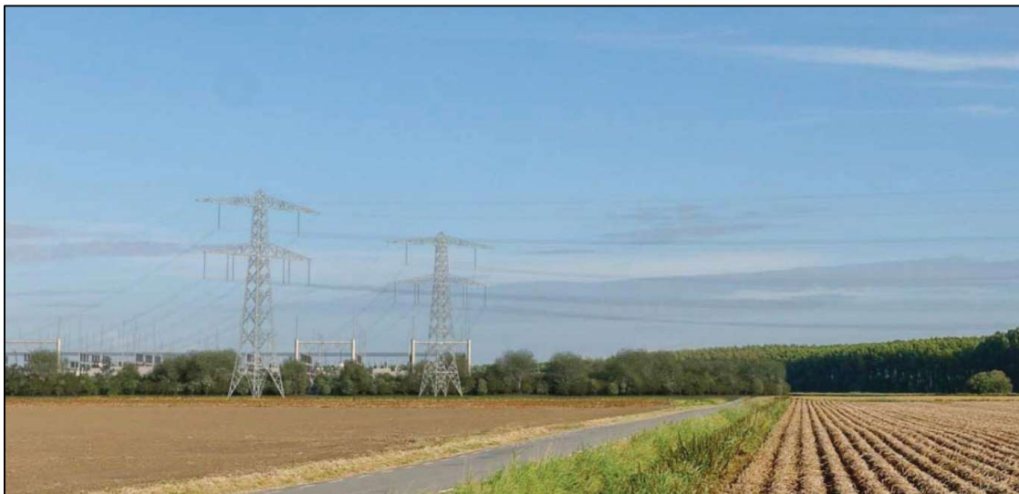
Afbeelding : Hogspanningsstation gezien vanaf de zuidzijde met landschappelijke inpassing
