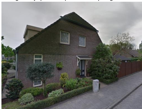
Bestaande bebouwing Kastanjelaan
