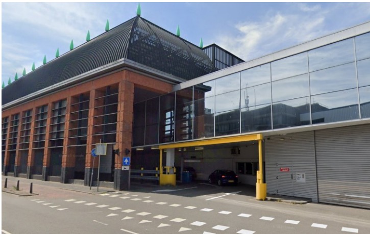
Figuur 1 Autotoegang parkeergarage de Parade
